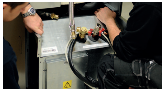
4. Dra ut kylmodulen genom att med hjälp av bärhandtagen först lyfta modulen något uppåt.
